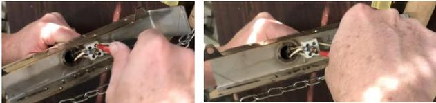
Desenrosque los tornillos que estabilizan los cables de la resistencia.
